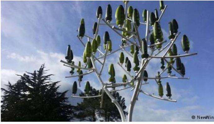
"شجرة الرياح" ابتكار فرنسي يحاكي الطبيعة لاستخراج الطاقة. ومبدع هذه الفكرة هو جيروم ميشو-لاريفيير، الذي استوحاها من أوراق الأشجار التي تحركها تيارات ضعيفة من الهواء. الهيكل يحاكي شجرة تحمل 72 مولداً صغيراً بدلاً عن الأوراق الطبيعية وينتج طاقة كهربائية تكفي لإنارة 15 مصباحاً أو شحن سيارة كهربائية أو إنارة منزل صغير.
